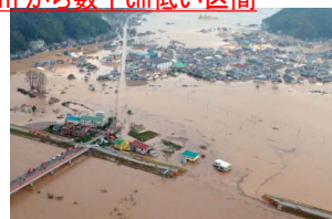
平成16年豪雨での円山川の破堤状況 国土交通省 ホームページより引用
