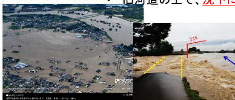
平成27年9月の関東・東北降雨による鬼怒川の破堤 国土交通省 ホームページより引用
