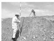
縦横断測量の実施風景
